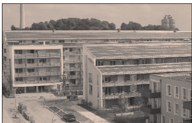
[그림 1] 건물지붕에 설치된 태양열집열기
